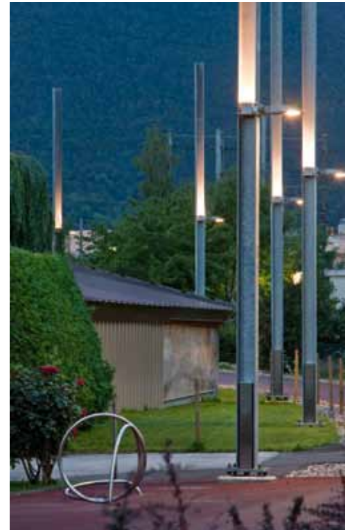
Die Leuchten wurden in die alten Strommasten der Bahn integriert.
